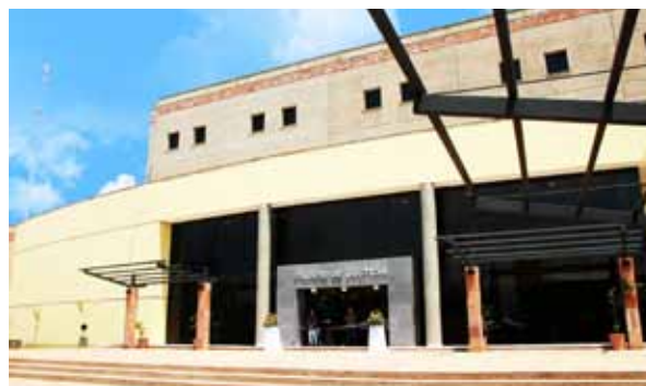
Palacio Judicial de San Pedro (en construcción)
