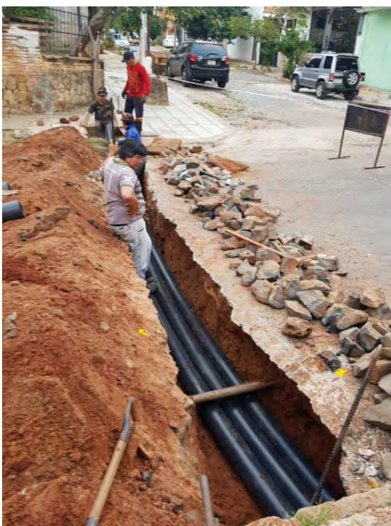
Trabajos para la Línea exclusiva de 23 kV, tramo subterráneo
