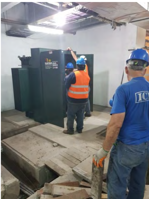
Montaje de un transformador de 1.500 kVA
