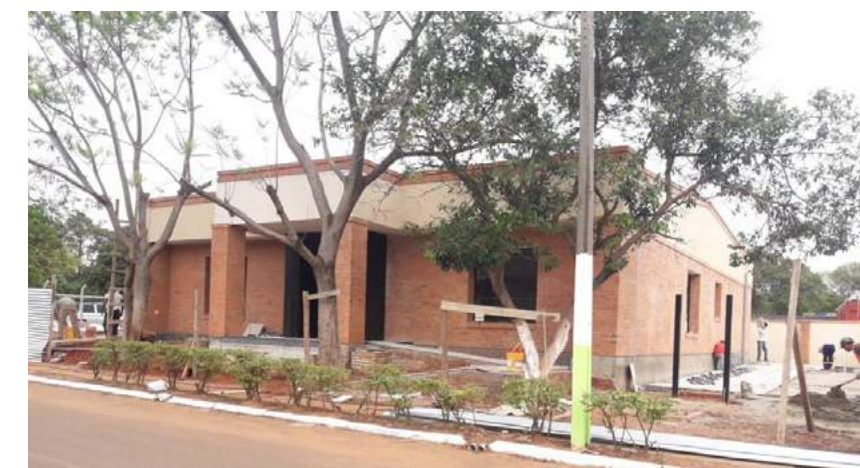
En construcción, el Juzgado de Paz de J. Augusto Saldívar
